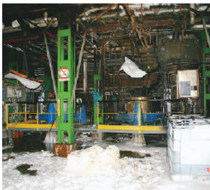
L'impianto dell'Unibios dopo l'incidente
