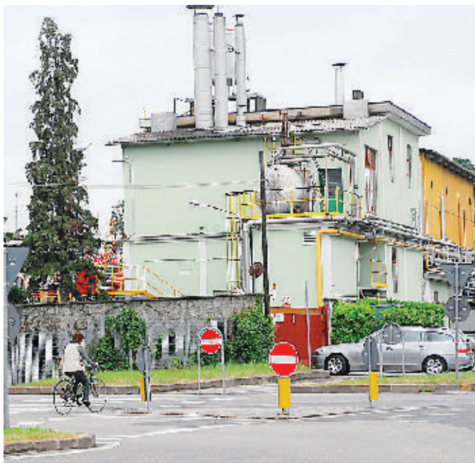
Gli impianti di via delle Rimembranze dell'Unibios a Treccate
